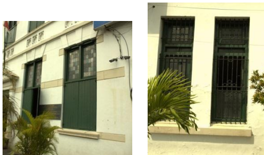
Gambar IV.22 (Penggunaan Material Jendela pada Bangunan Lama dengan Bangunan Baru)
