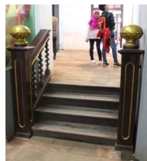
Gambar IV.20 (Penggunaan Material Tangga pada Bangunan Lama Lantai di Lt.1)
