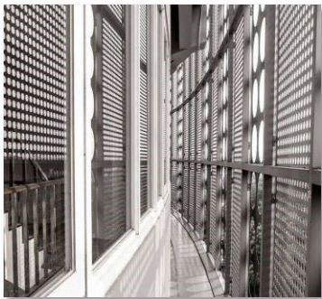
Gambar 2. Buffer Sistem pada Bangunan UMN Penerapan Double Skin
