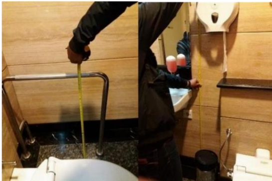
Gambar 14 Handrail Toilet Difabilitas dan perletakan tisu
