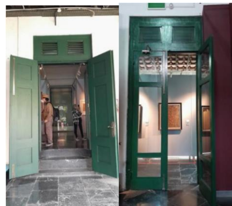
Gambar 9 Bukaan pada Pintu, Dan Kusen (Sumber : Dokumentasi Penulis, 2022)
