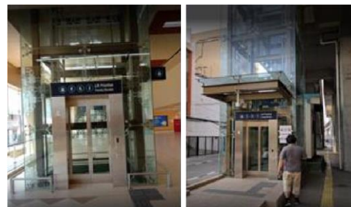
Gambar 4.5. foto existing posisi lift elevator stasiun MRT Haji Nawi
