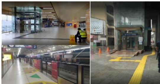
Gambar 4.3. foto existing posisi Guiding block stasiun MRT Haji Nawi
