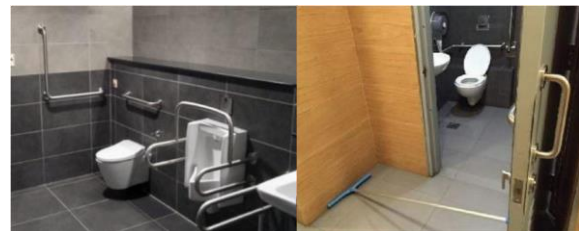
Gambar 4.7. foto existing toilet difabel stasiun MRT Haji Nawi
