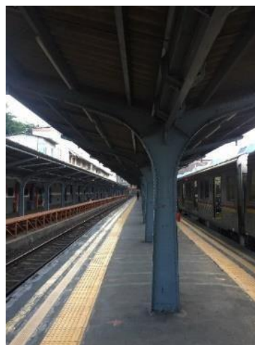
Gambar 8 : Buterfly Shed Adapun dari segi bangunan dalam stasiun ini terdapat dua lantai.
