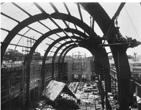
Gambar 6 : Pilar baja penyangga atap Sedangkan untuk struktur
