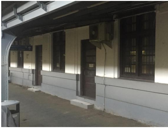
Gambar 11 : Tampak dinding fin. cat
