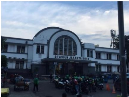
Gambar 3 : Fasad depan yang terbentuk mengikuti sistem rangka Barrel Vault
