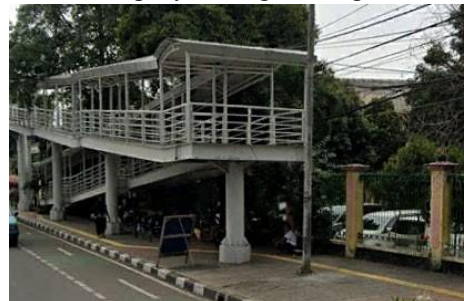
Gambar 4. 12 Jalur penyeberangan orang Sumber : dokumentasi pribadi
