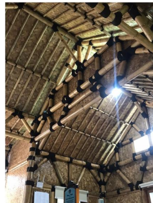
Gambar 11 Penggunaan Lampu LED (Sumber: Dokumentasi Pribadi, 2025)
