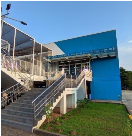
Gambar 3. Pintu masuk utama
