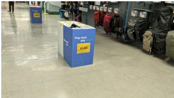
Gambar 7. Lantai beton ekspos
