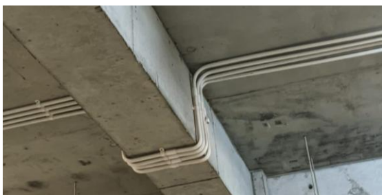
Gambar 12. Struktur balok beton ekspos
