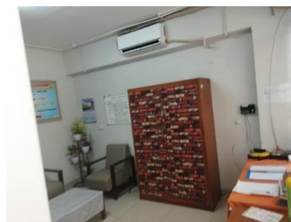
Gambar 13. Outdoor AC Central (Sumber: Dokumentasi Pribadi, 2024)
