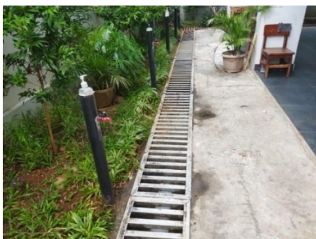
Gambar 16. Drainase Sekolah (Sumber: Dokumentasi Pribadi, 2024)
