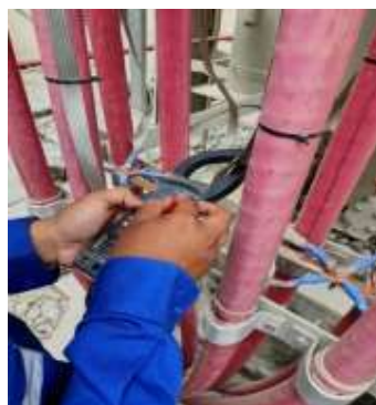
Gambar 3.4 Monitoring arus Bocor pada kondisi beroperasi
