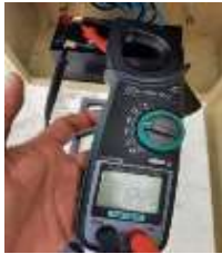
Gambar 3. 17 Pengukuran Tegangan Baterai 12 Volt
