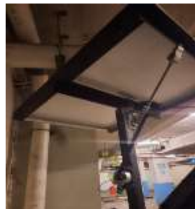
Gambar 2. 9 Tracking Solar (sumber : Dokumen pribadi)
