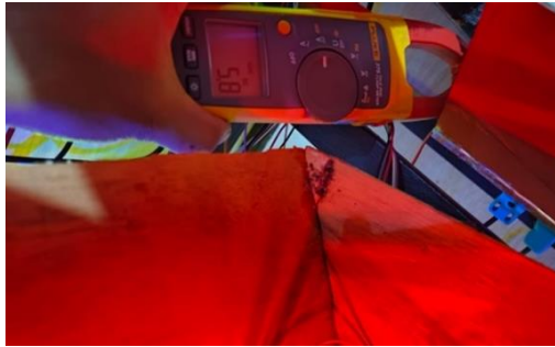
Gambar 3. 11 Tegangan tidak ada sampah
