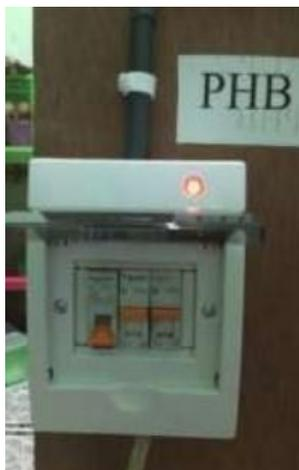
Gambar IV.4.3. 3 Kondisi RCBO setelah bagian stop kontak dihubungkan ke tanah
