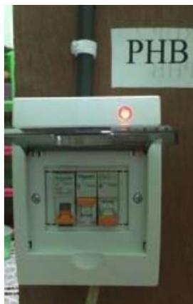
Gambar IV.4.2. 2 Kondisi RCBO setelah terjadi hubungan singkat pada beban
