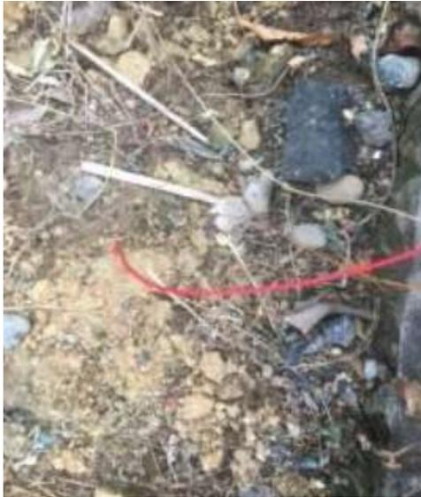
Gambar IV.4.3. 2 Kabel yang menghubungkan bagian fasa dari stop kontak dengan tanah
