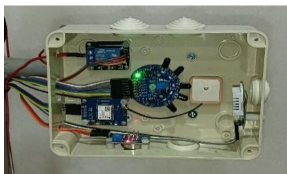
Gambar 5. Perangkat Pembangkit Listrik Energi Surya
