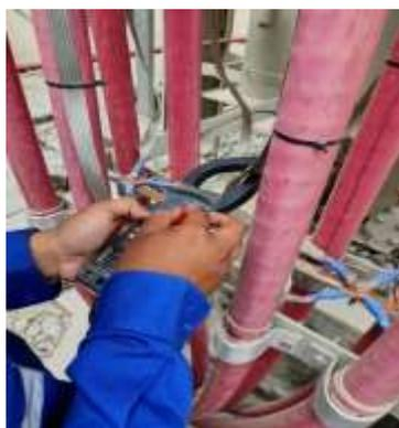
Gambar 3.4 Monitoring arus Bocor pada kondisi beroperasi
