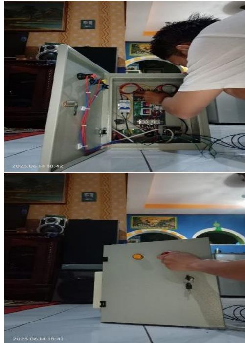
Gambar 10. Proses Perakitan Panel
