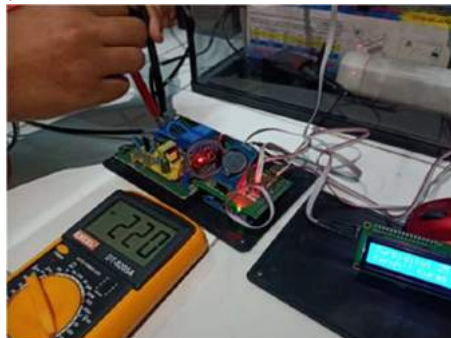
Gambar 7. Pengukuran Tegangan Saat Pompa Kuras Aktif
