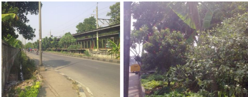
Gambar 4 Kondisi Tepi Jalan Ruas Kedua
