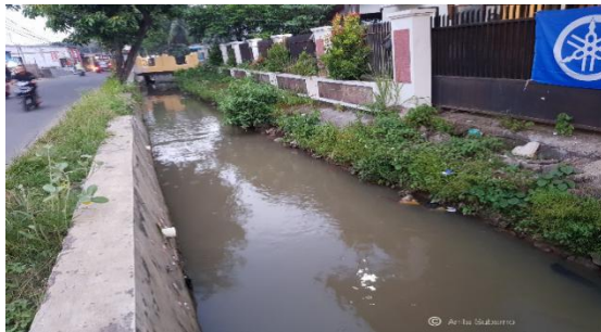
Gambar 1. Selokan pembuangan di Depok Untuk melihat dan membandingkan kualitas air tanah di daerah yang memiliki sumber pencemar yang berbeda yaitu dari industri dan domestik rumah tangga, maka penelitian terhadap kualitas air tanah ini dilakukan di dua wilayah yang berbeda, yaitu Kota Depok dan Kabupaten Bekasi. Depok yang terkenal sebagai daerah pemukiman penduduk terletak di provinsi Jawa Barat, Indonesia. Kota ini memiliki luas wilayah 200.29 km 2 dan terletak di koordinat 6° 23' 24" LU 106° 49' 48" BT / 6.39° LS 106.83° BT.
